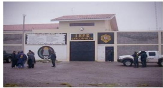
Establecimiento penitenciario de Challapalca
